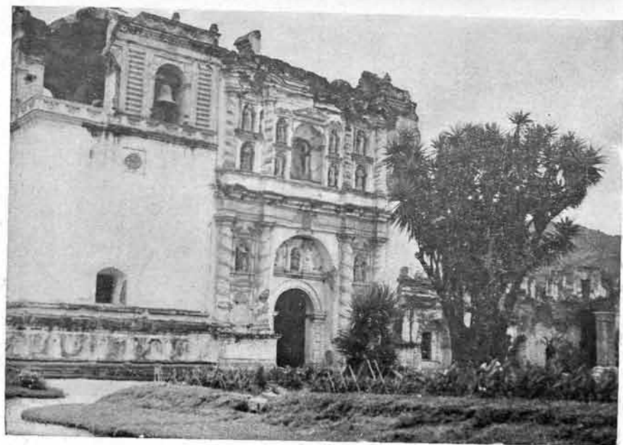
Fig. núm. 44.—Ruinas del templo de San Francisco. "La Antigua" (Guatemala).
